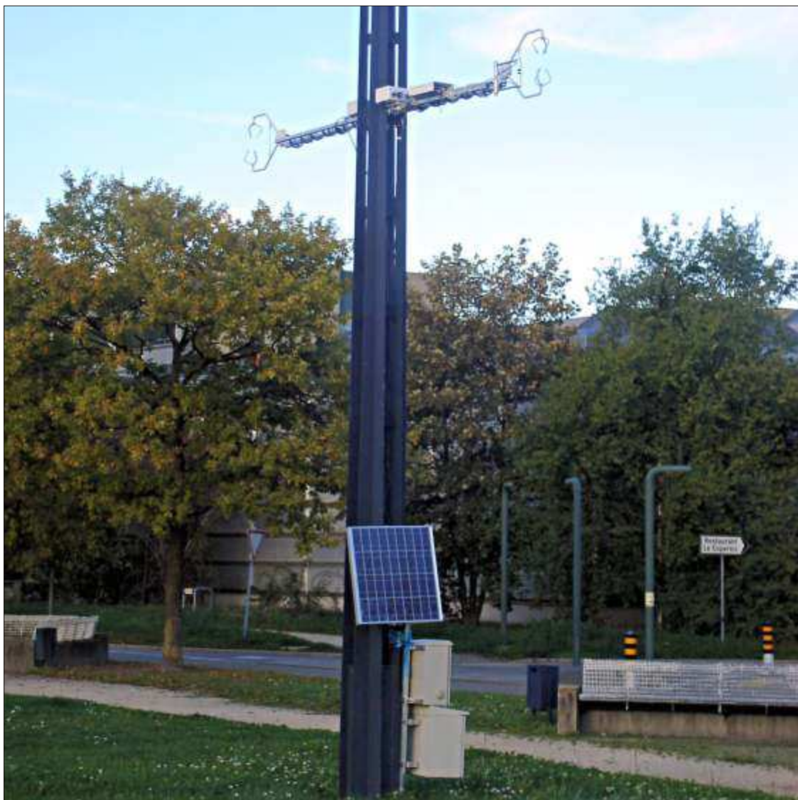
Un radiophare pour permettre la localisation du site de l'EPFL a été installé pas loin du pavillon jaune.
