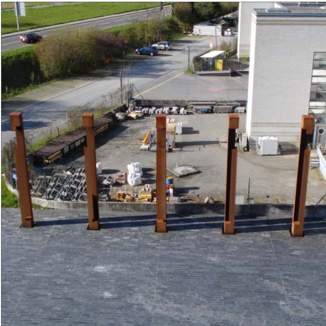
Les résidus de ferraille gisant depuis de nombreuses années face à l'entrée du bâtiment BC seront enfin déblayés.
